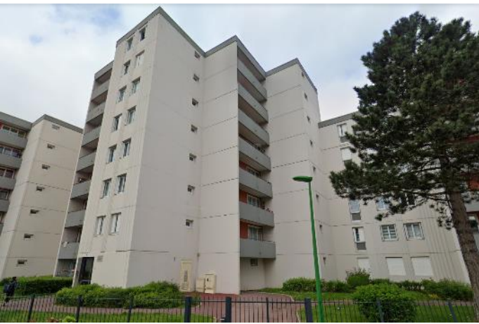
Figure 4.12 Exemple d'un immeuble fin des années 1970 à Charleville-Mézières (R+7) (AUDRR)
