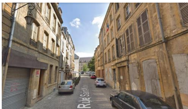
Figure 4.16 Centre historique de Sedan avec un bâti homogène remarquable (source Google street view)
