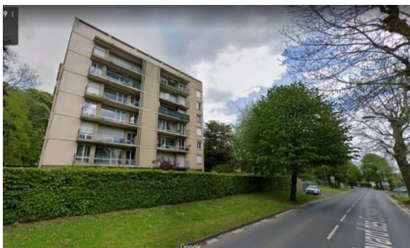
Figure 4.34 Immeubles plots discontinus à Sedan (source Google street view)
